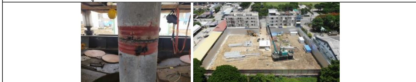
รูปที่ ๗7.22 การใช้เสาเข็มแบบกด JIP (Jack In Pile) ในช่วงก่อสร้างฐานราก
